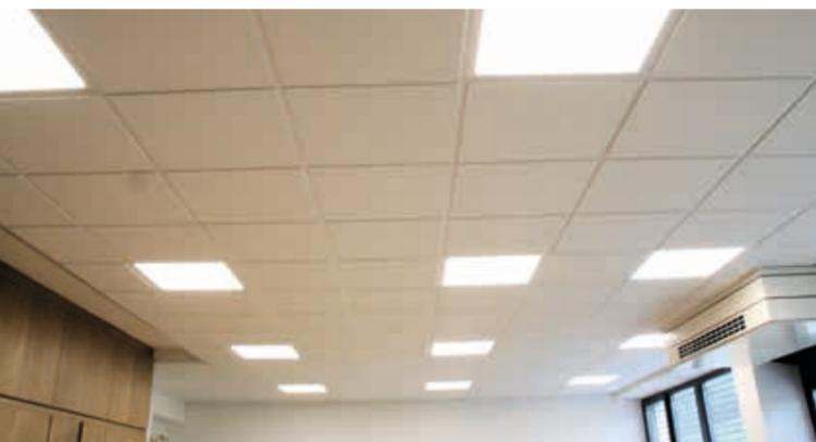
Akustikdecken in den Klassenräumen und im Konferenzzimmer und Austausch der alten Neonröhren. Diese wurde durch moderne, energiesparende LED-Beleuchtung ersetzt.
