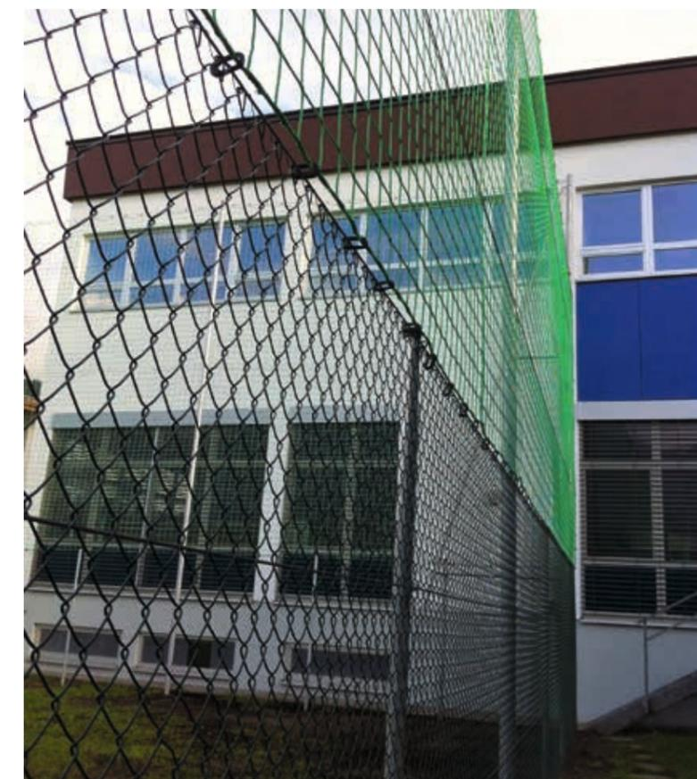
Neue Einzäunung des Sportplatzes – 8 m und 10 m hoch – mit Gittern im unteren Bereich und mit Netzen oben
