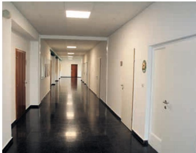
Entfernung der dunklen Holzschalungen in Gängen und Nebenräumen – ersetzt durch weiße Schallschutzdecken
