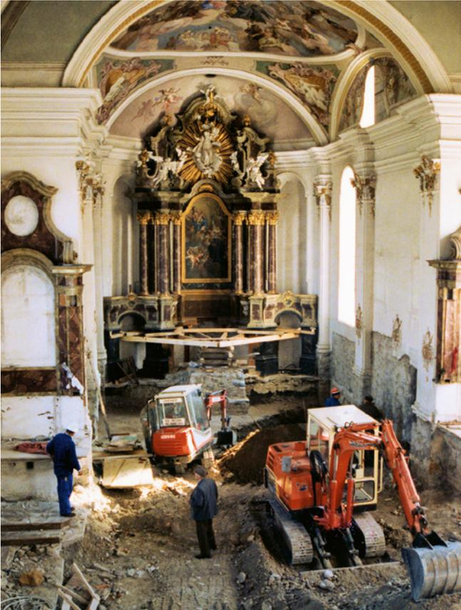
**15. 4. 1991:** Im Rahmen der Kirchenrenovierung entfernte man mit Baggern den alten Kirchenboden, der durch einen neuen ersetzt werden sollte.
