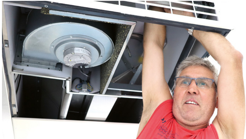
2022: Filtertausch Raumbelüftung
